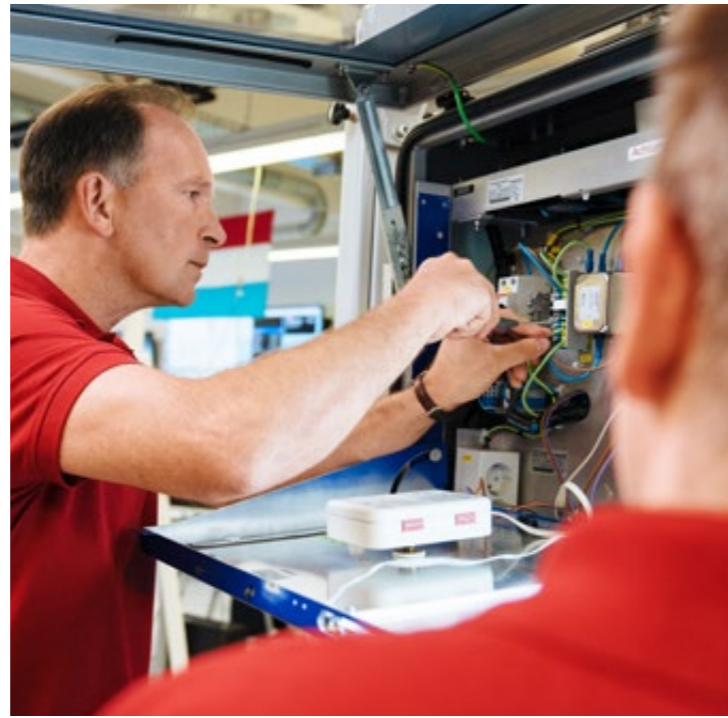
Gerold Meinders ist ein Spezialist für die Installation von Fahrgastinformationsanzeigern.
