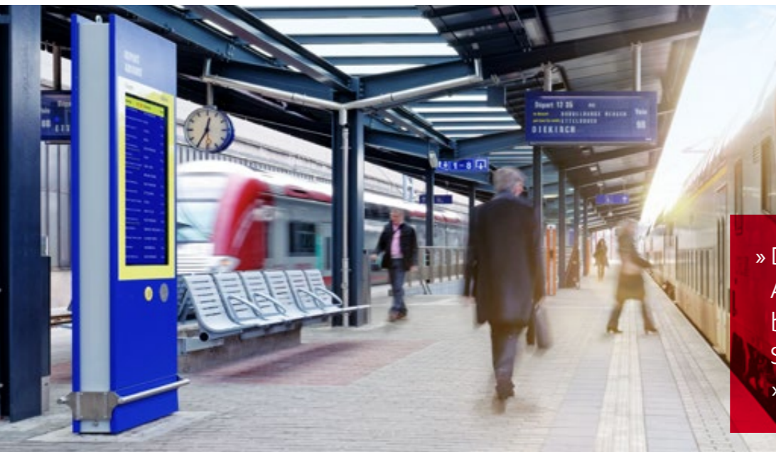
Vollautomatisierte Reisendeninformation von Funkwerk bei der Bahn in Luxemburg
