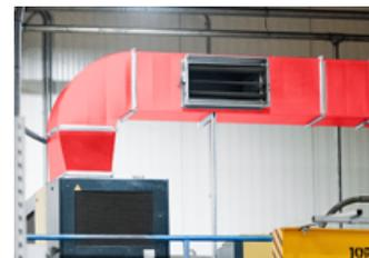
Luftleitungen verteilen die Abwärme der Laserschneidanlagen.
