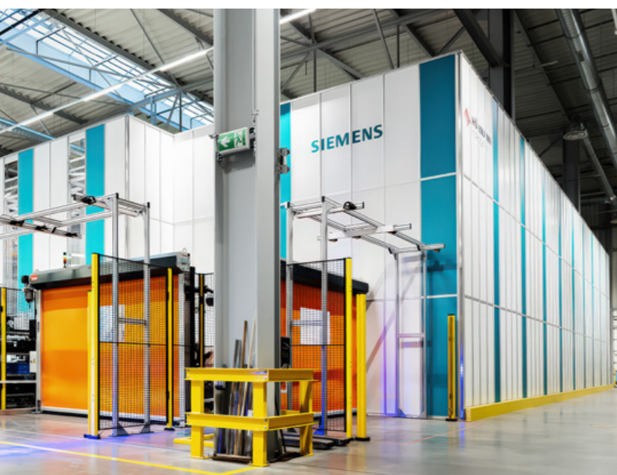
^ Pickroboterzelle und AutoStore®-Anlage von außen
